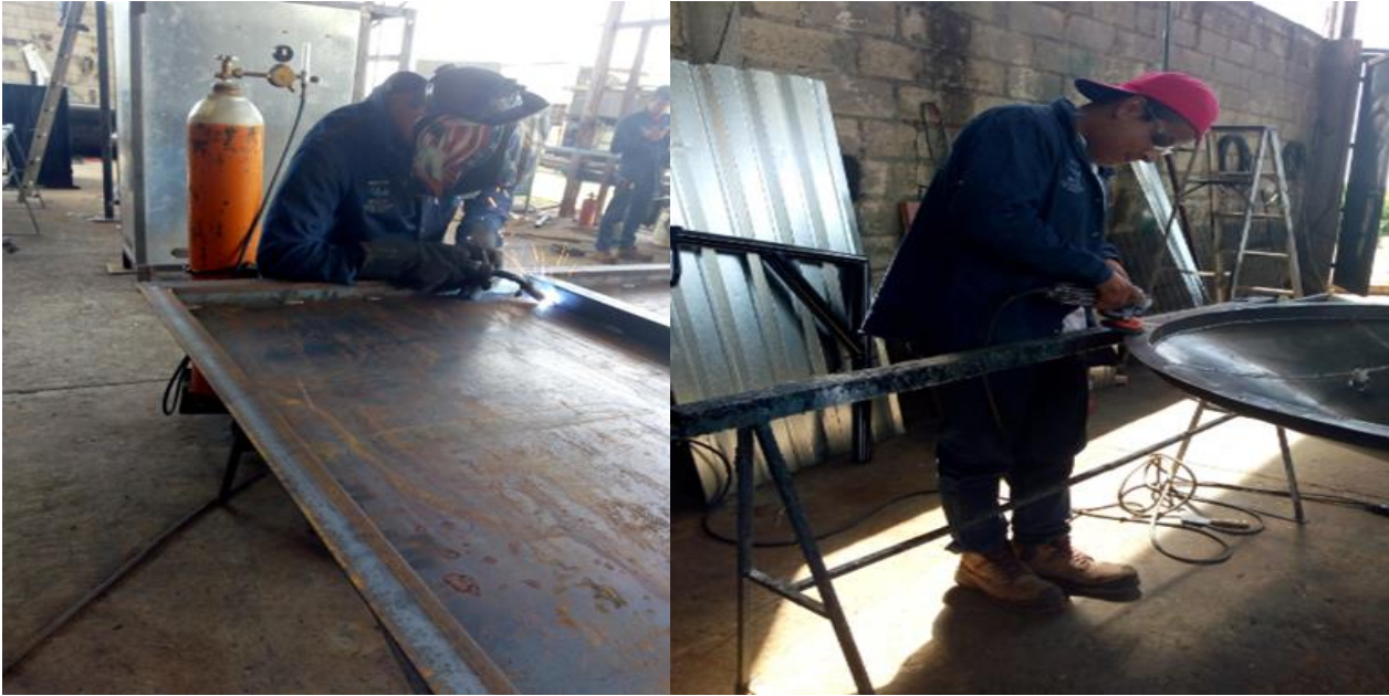
Figura 7. Fabricación de la estructura metálica de soporte
